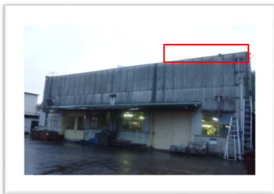
” 第一工場北側屋根補修”
